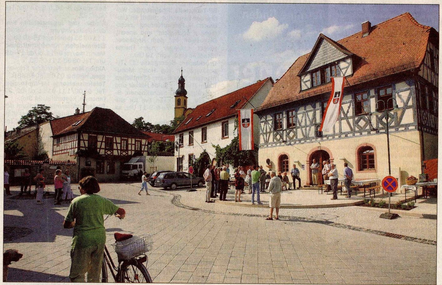
Nach der Sanierung lässt der Carl-Zuckmayer-Platz die umliegenden Gebäude besser zur Geltung kommen. Foto: hzb / Michael Bahr
